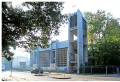
Der neue Eigentümer hat das Gelände der früheren Propsteikirche an der Emil-Fuchs-Straße einzäunen lassen. Zu seinen Plänen gibt er keine Auskunft. Von der Rechtslage her müsste er den Abriss nur noch vier Wochen vor Beginn bei der Stadt anzeigen. Foto: André Kempner
